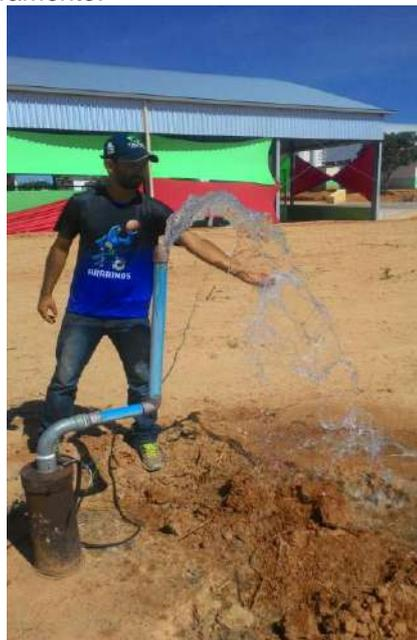
**Figura 2.** Teste de vazão e reativação do poço artesiano 03.
