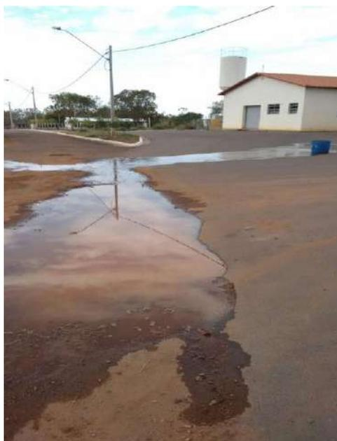
**Figura 3.** Vazamento com escoamento superficial na tubulação de captação do poço artesiano 01.
